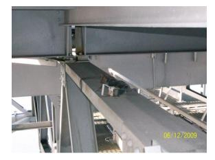
P.P.65 S.E. REDUNDANT RATCHET STRAPS REQUIRE TO BE REMOVED.
