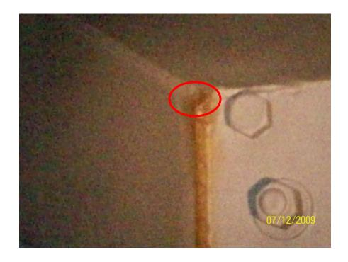
**STAGING REQUESTED**: FOR INSPECTION TO POTENTIAL WELD CRACK TO CYCLE TRACK SOFFIT, LOCATED AT P.P.64 S.E.
