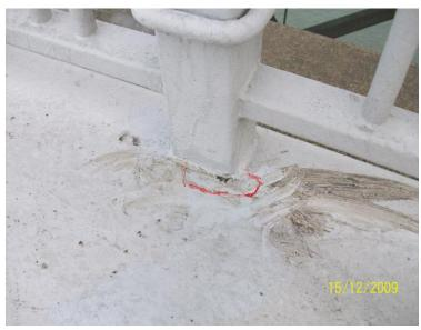
P.P.52 S.W. BASE WELD CRACKED AT POST SOUTH OF P.P.
